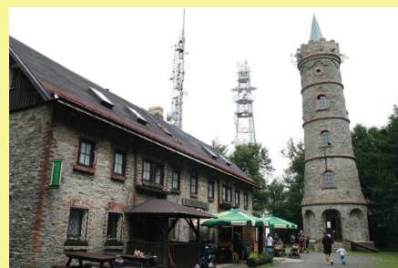
Budeme-li se ovšem pozorně dívat kolem sebe, zjistíme, že některé nové role krajiny jsou vlastně celkem staré. Rozhledna Jedlová v Lužických horách, postavena roku 1891.
