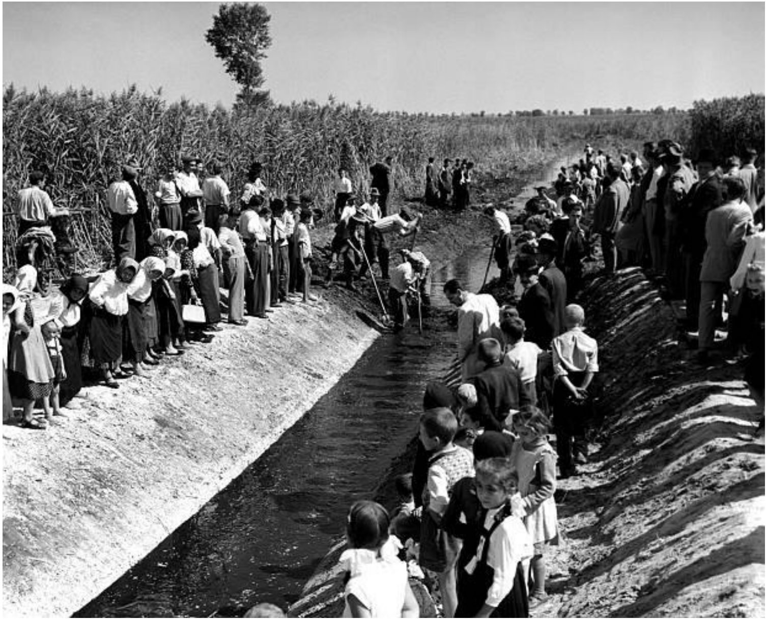
Drainage of the ,dirty waters' of Nagy-Csukás Lake, 1958 (MTI Fotó)
